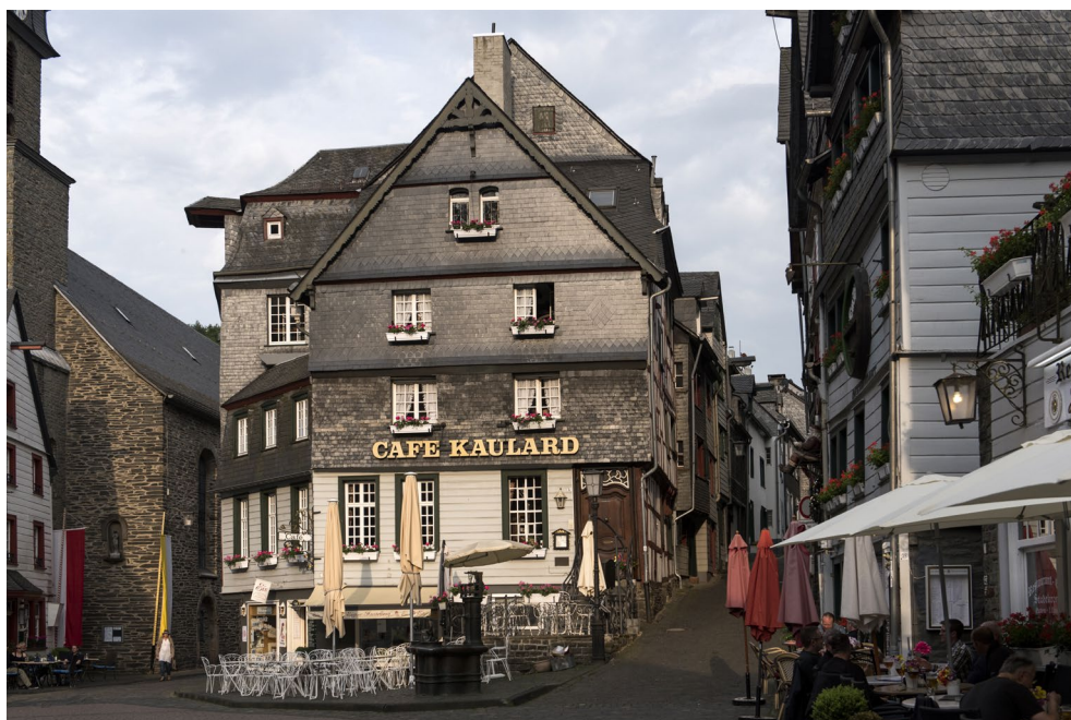
B5 Monschau - Im Rahmen des "Wohnumfeldprogrammes" konnte die Fassadensanierung mehrerer Gebäude gefördert werden
