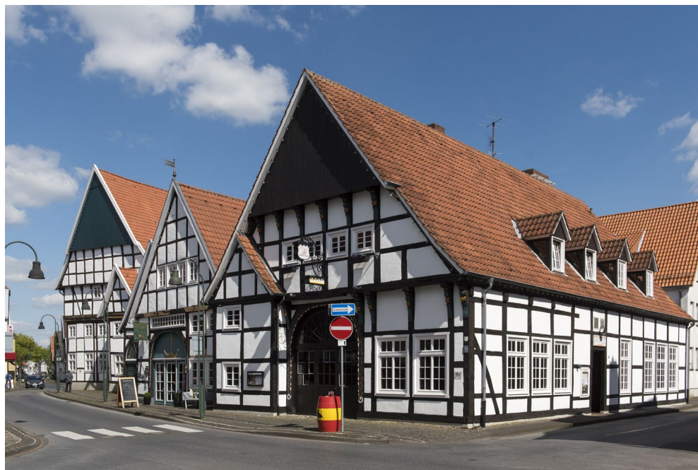
A1 Wiedenbrück - Wie in vielen Historischen Stadt- und Ortskernen sind auch in Wiedenbrück eine Vielzahl von Einzelgebäuden durch Eintragung in die Denkmalliste geschützt
