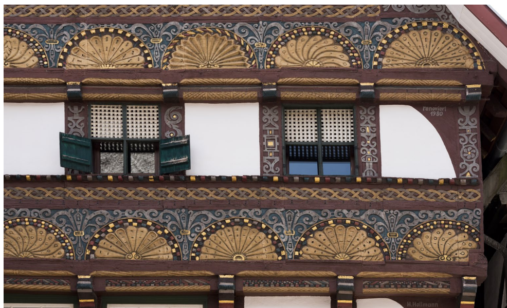
Fassadengestaltung mit Schnitzwerk an einem Fachwerkbau aus dem 17. Jahrhundert in Bad Salzuflen
