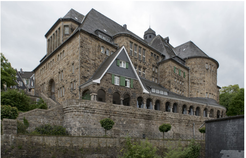
C5 Velbert Langenberg - Das Bürgerhaus in Langenberg konnte mit Fördermitteln des Landes NRW saniert werden
