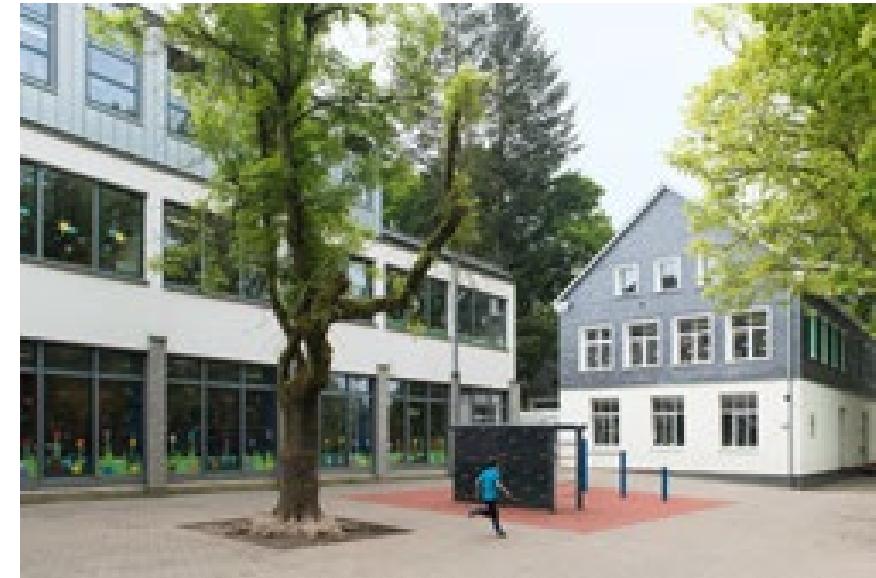
Neuer Klassentrakt der Grundschule mit historischem Schulgebäude
